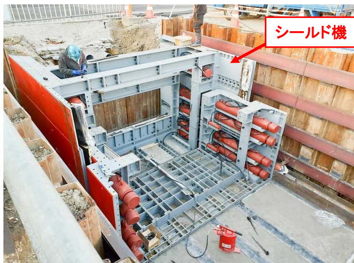
△ 施工状況 : シールド機組立
