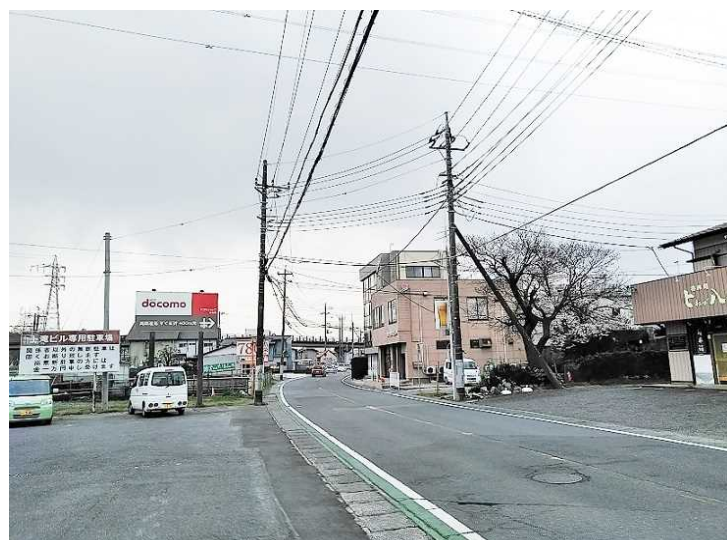
△ 施工前状況 : 県道より横断部を見る
