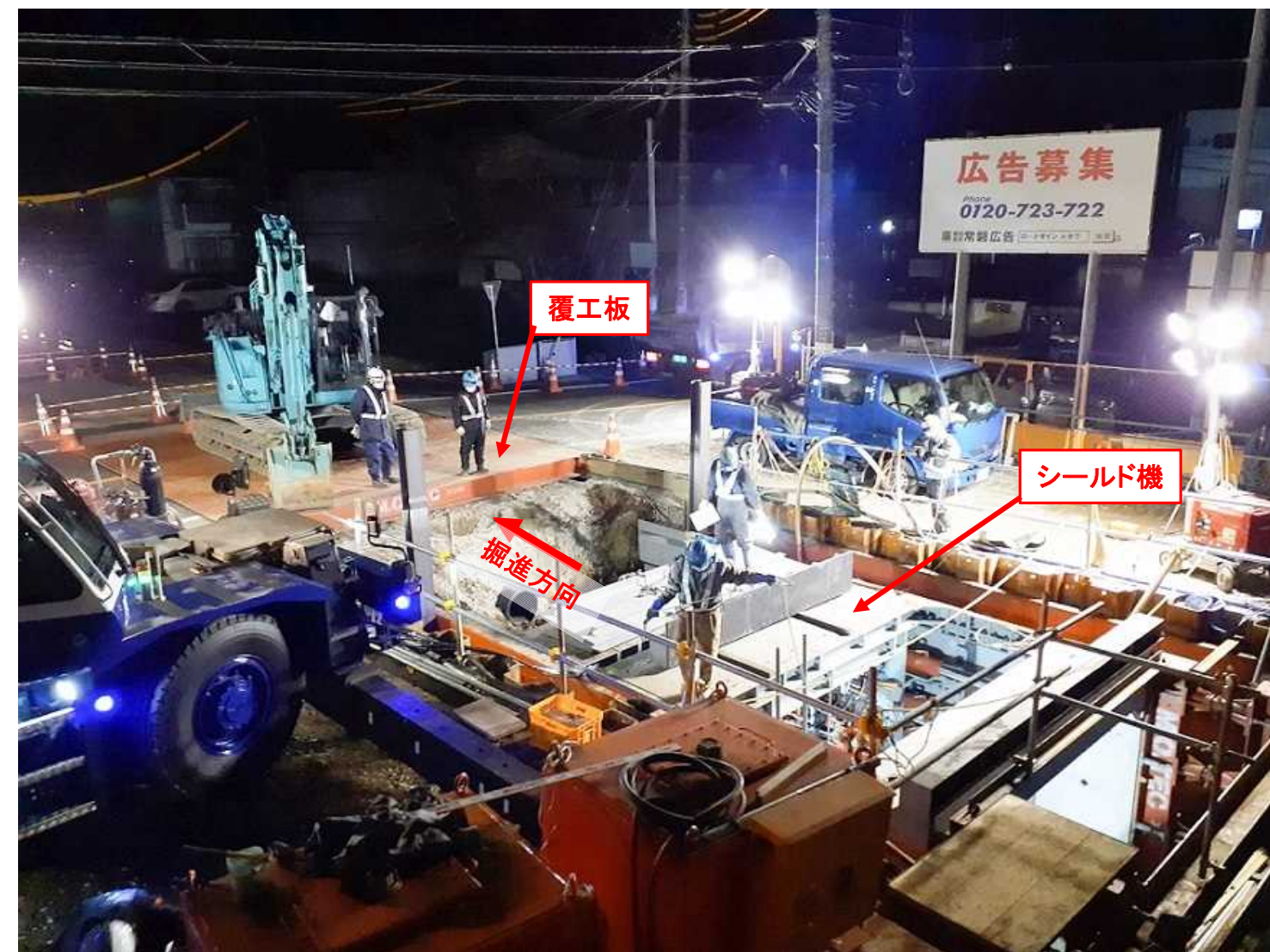
△ 施工状況 : 全景
