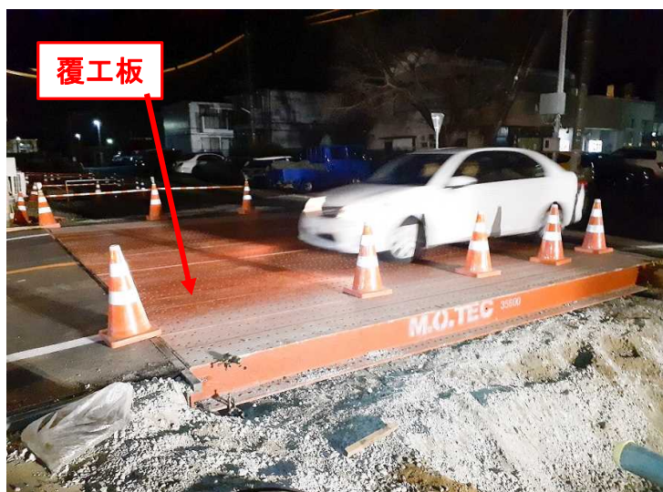
△ 施工休止時 : 県道路面覆工状況
