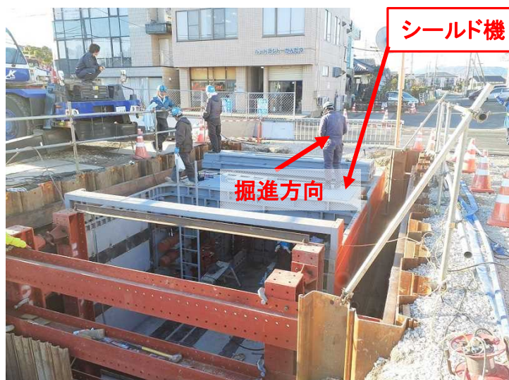
△ 施工状況 : シールド機組立
